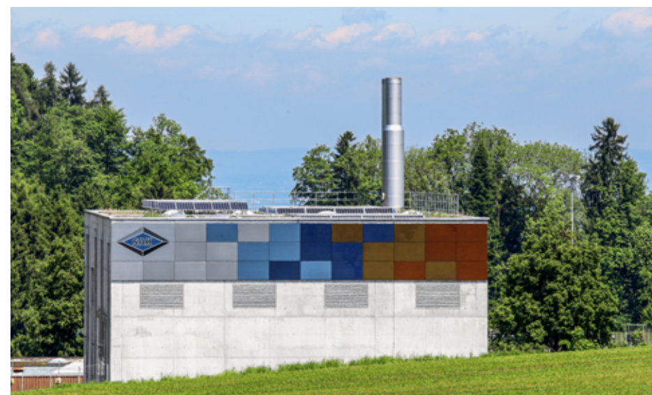
Die farbenfrohe Heizzentrale in Wittenbach SG: Sie ist auch ein Solarkraftwerk.
