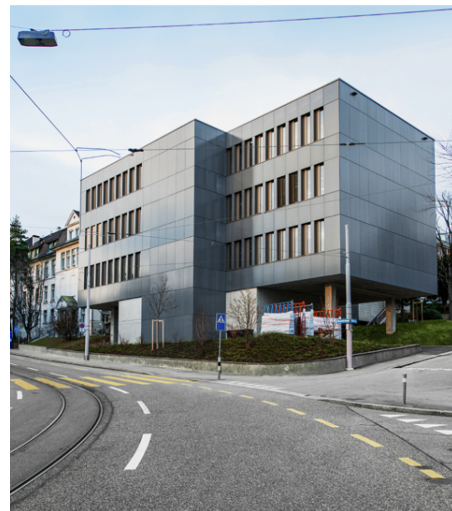
Ist mit fensterhohen Photovoltaikmodulen bestückt: Der Büro- und Laborbau GLL des Instituts für Medizinische Mikrobiologie an der Universität Zürich.
