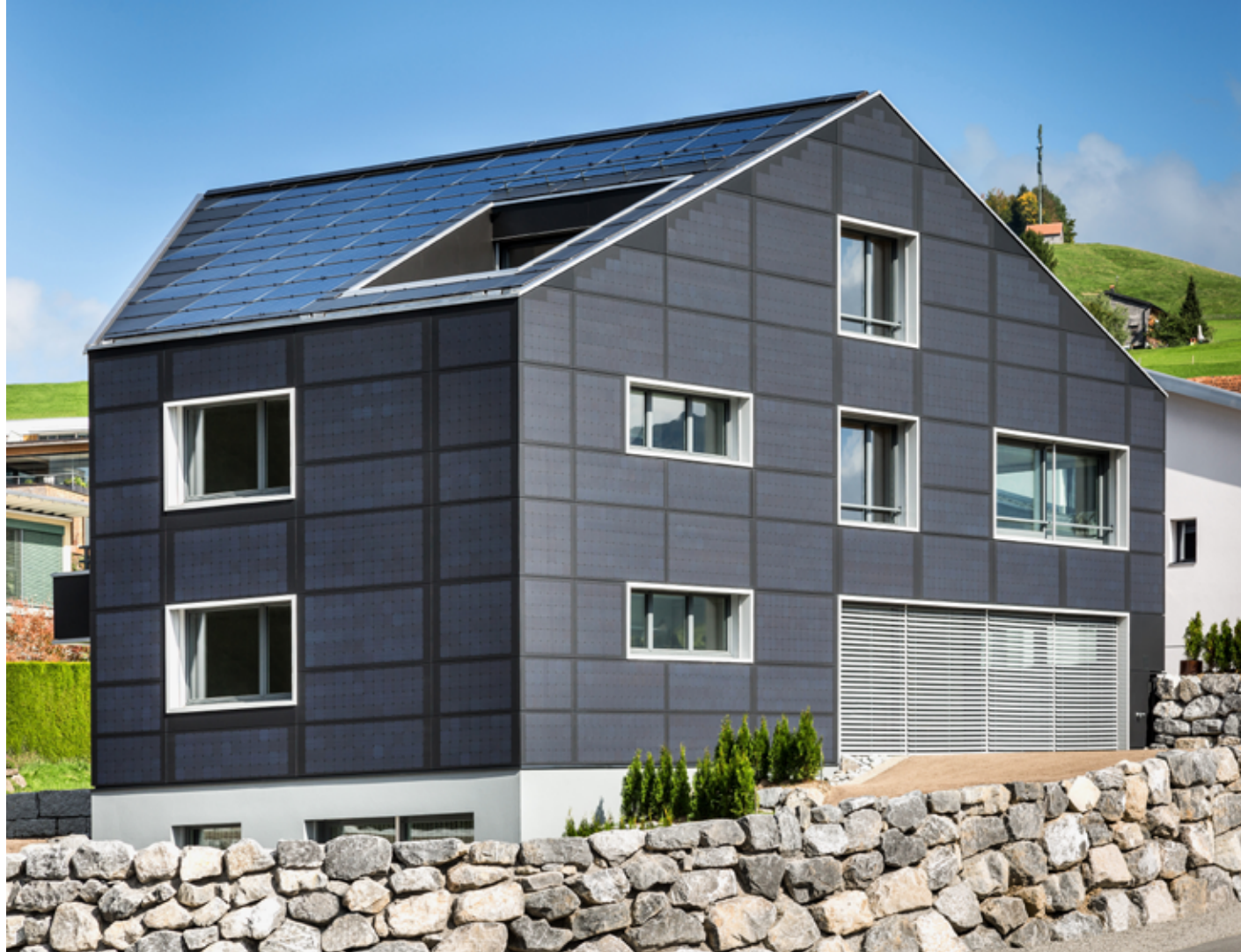
Das 2017 in Appenzell fertiggestellte Mehrfamilienhaus Ebnetor: 300 Quadratmeter Photovoltaik finden auf der schmucken Gebäudehülle Platz.
